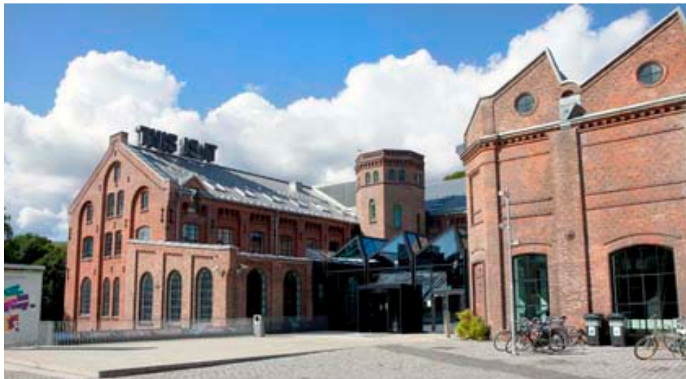
Kunsthøgskolen i Oslo holder til i Fossveien 24 på Grünerløkka, i den ombygde Seilduksfabrikken, rett ved Akerselva. Foto: KHiO
